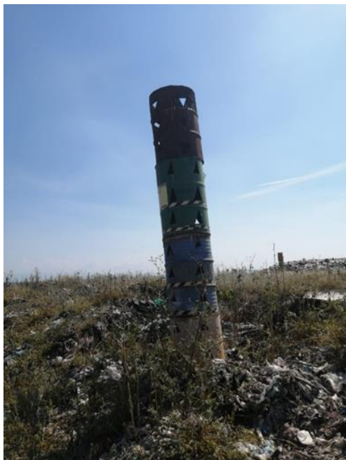
Pozos de extracción de biogás 2
