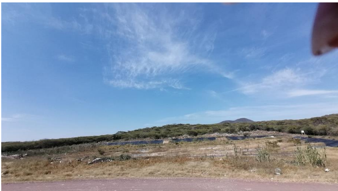
Imagen 11 Celda de emergencia.
