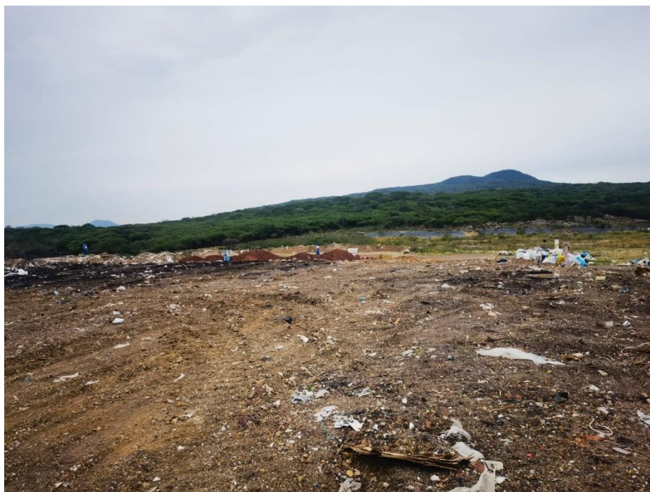
Vista después de la compactación
