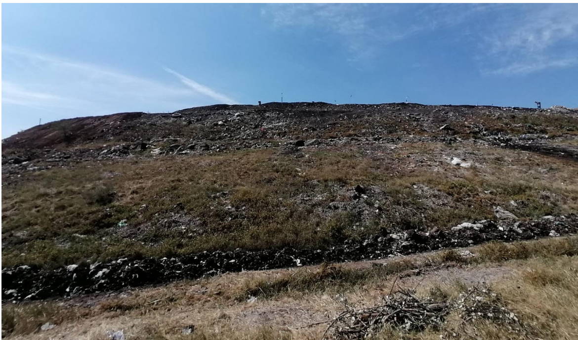
Fotografía 17. Talud trabajado por el método de trincheras
