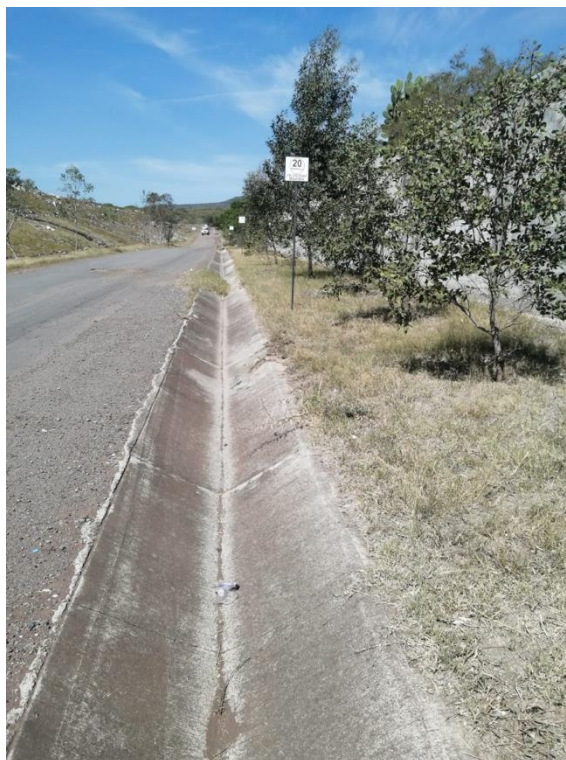
Canaletas pluviales
