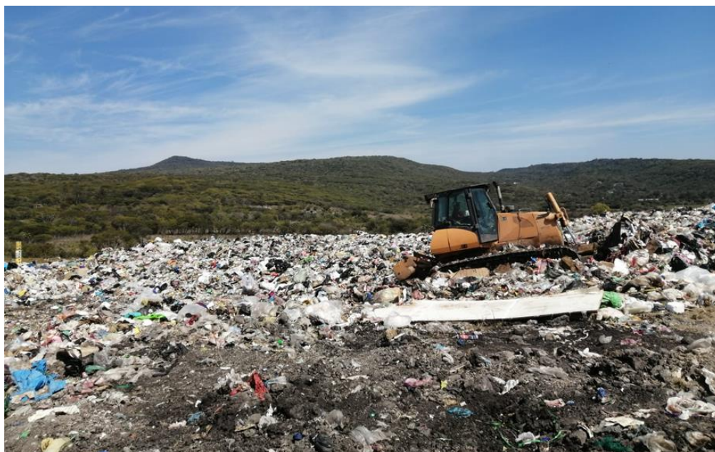
Bulldozer haciendo trabajos de compactación en la zona de tiro del sitio de disposición final
