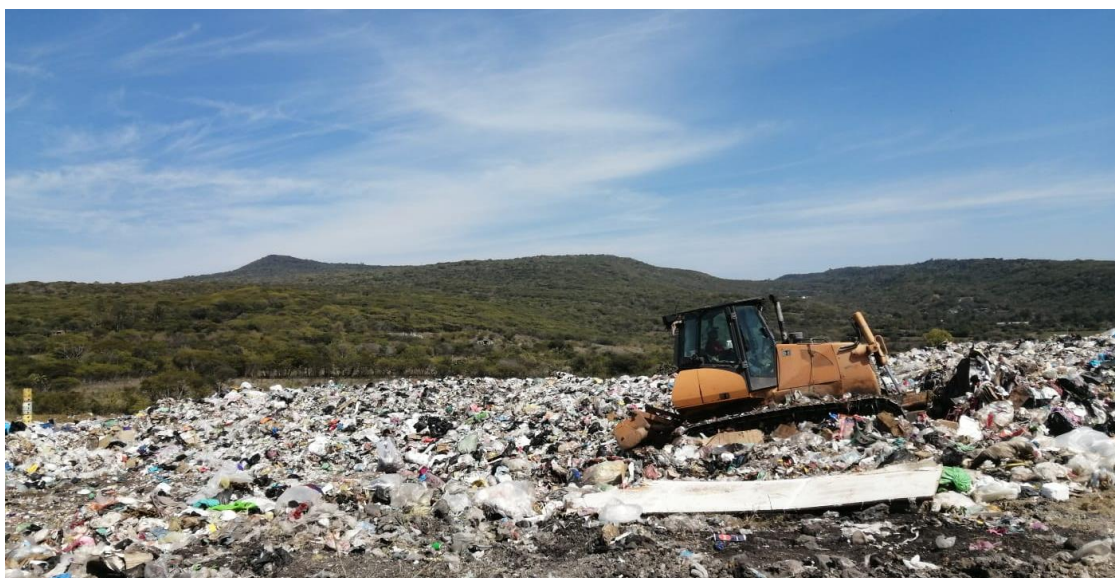
Fotografía 16. Bulldozer haciendo trabajos de compactación en la zona de tiro del sitio de disposición final
