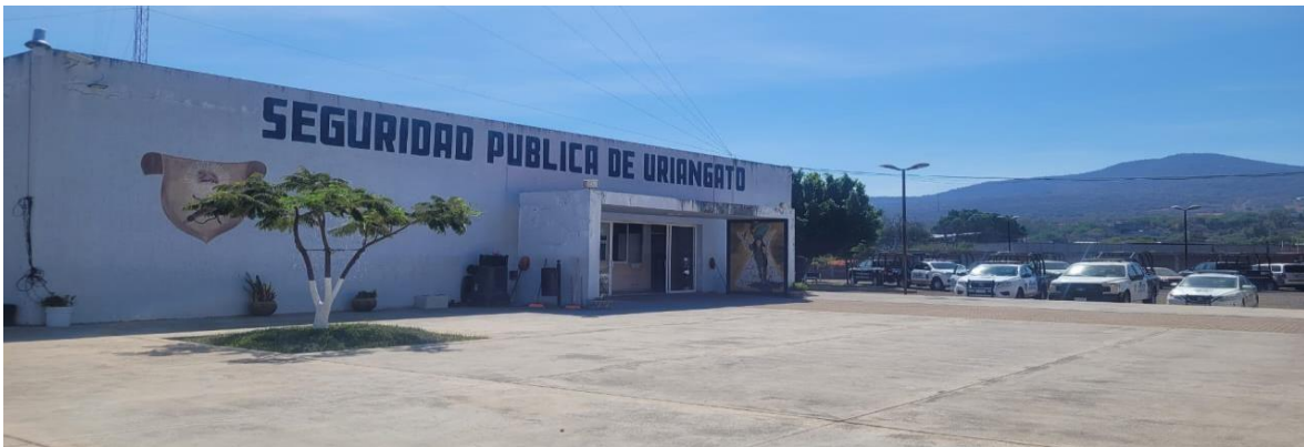
(Instalaciones de seguridad pública municipal Uriangato)
