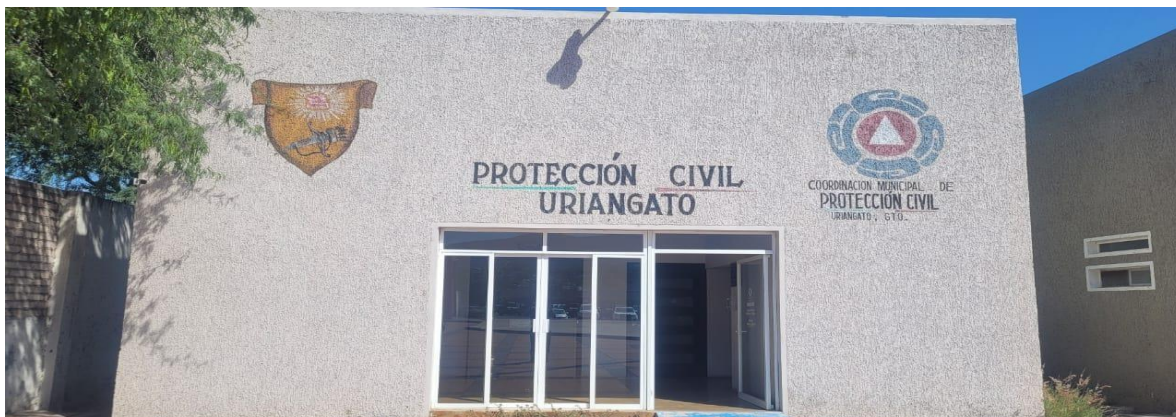
(Instalaciones de la coordinación municipal de protección civil Uriangato)
