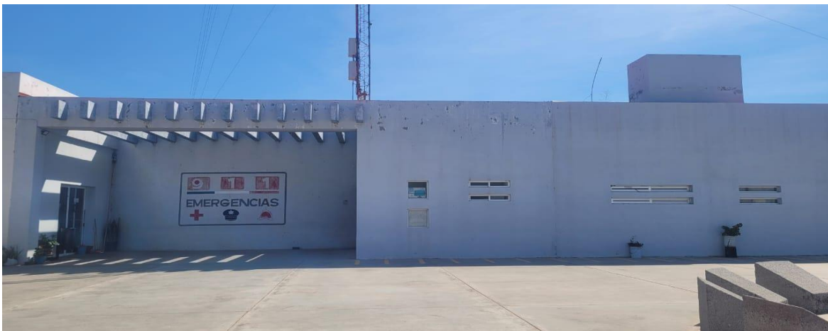
(Instalaciones del sistema de emergencias 911 Uriangato)
